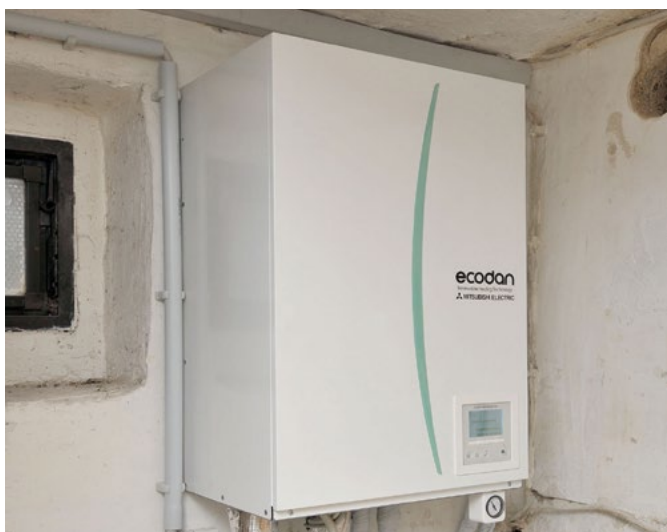
Das Hydromodul sorgt für eine effiziente Energieübertragung vom Kältemittel auf das Heizungswasser
